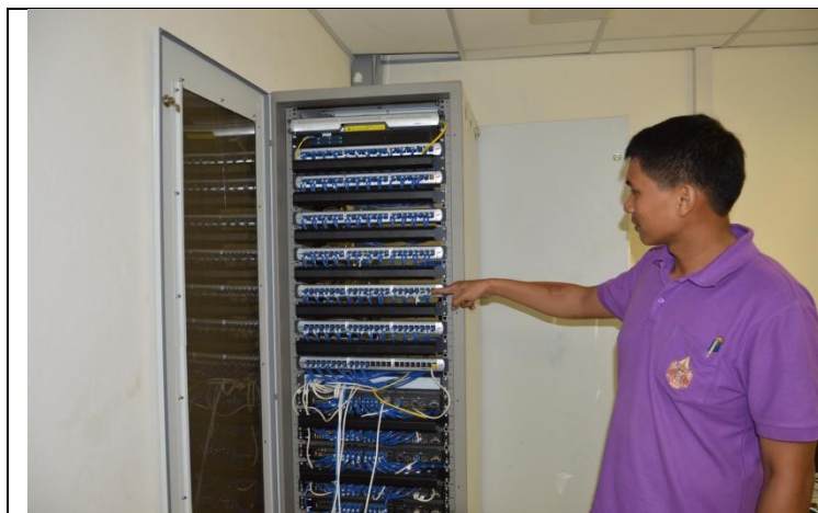
*wifiชั้น 2 และ 3 ถูกต่อเข้ามาที่ตู้ Rack ณ ห้องควบคุมที่ Port9-10 RACK U21
